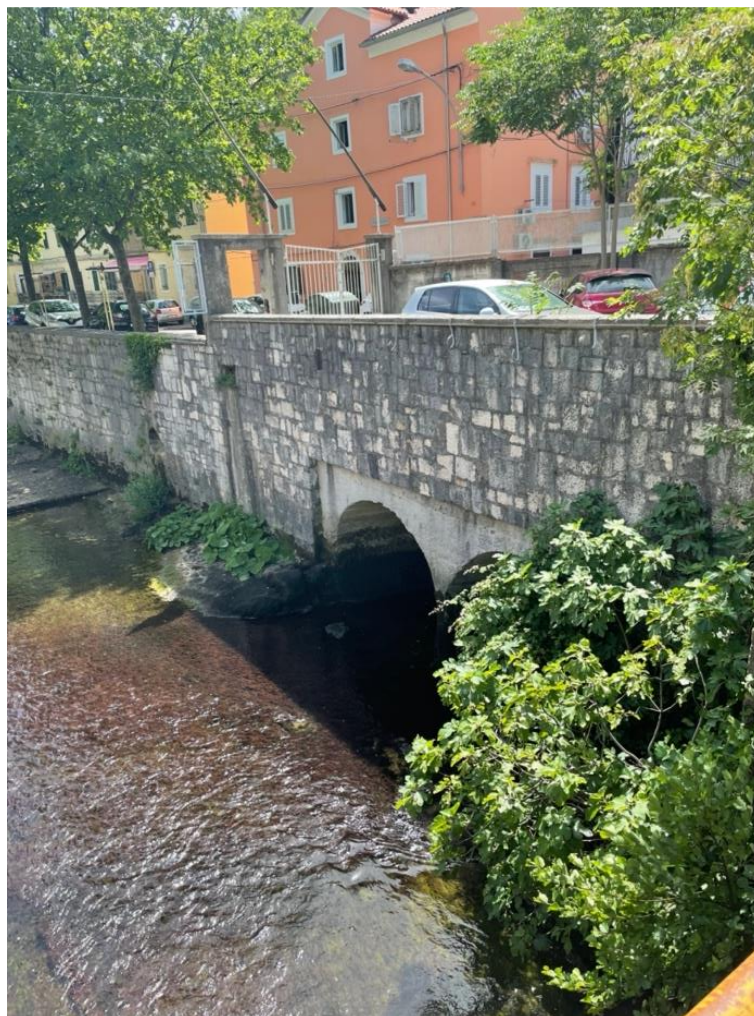
Slika 3.9. Ispust iz odvodnog kanala HE Rijeka
