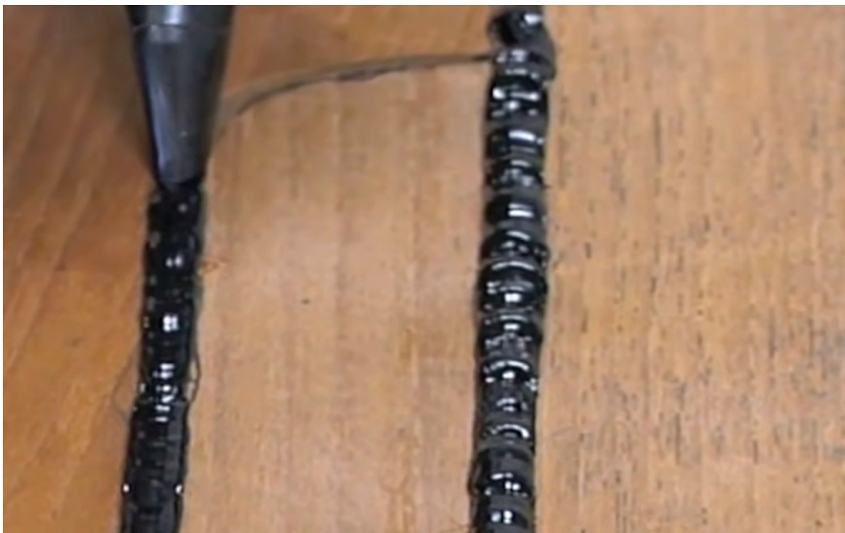
Slika 2.10. Brtvljenje trenica palube [11]
