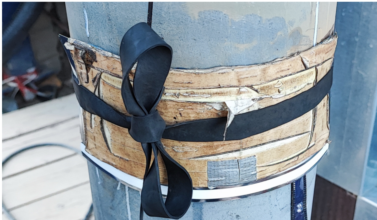
Slika 4.15. Postavljeni film na zavaru
