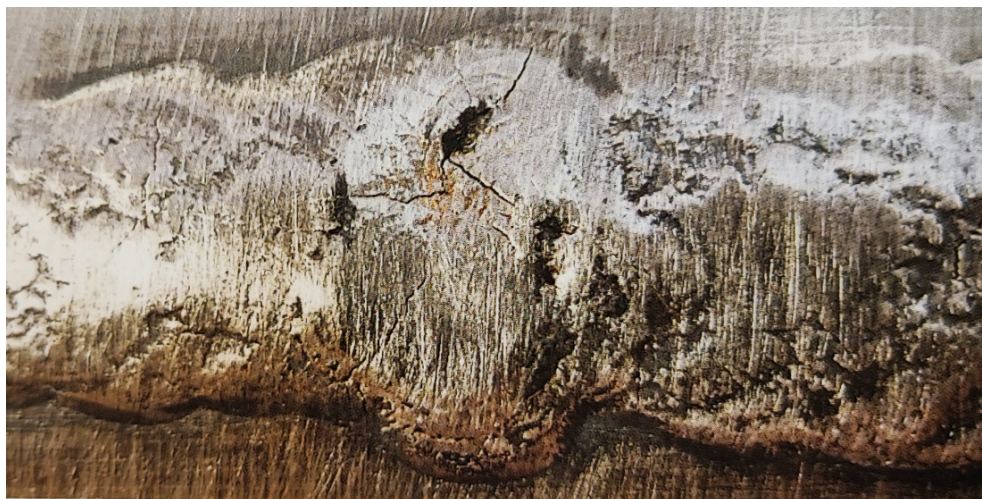
Slika 3.3. Zvjezdasta pukotina u zavaru [5]
