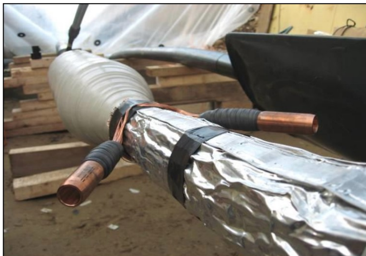
Slika 5.5. Primjer izrade kableske spojnice preplitanjem zaslona [1]
