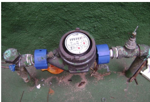
Slika 2.4. Hidrometar [2]
