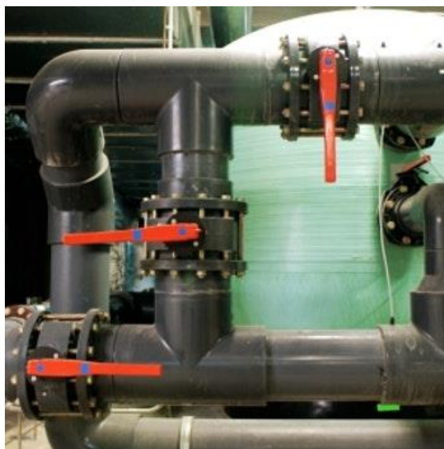
Slika 6. ABS cijevi i prirubnice [4]
