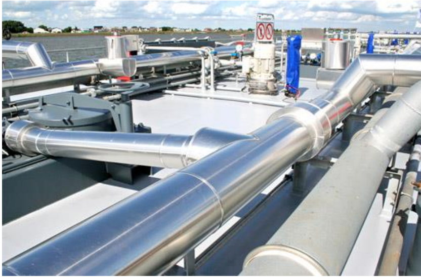
Slika 8. VEKA cijevi na tankeru [5]
