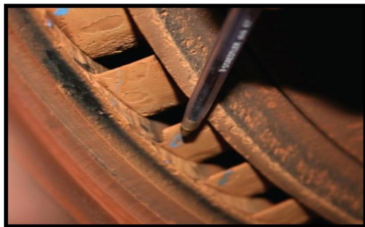
*Slika 3.2. Primjer posljedice neravnomjerne raspodjele pare uslijed korozije*
