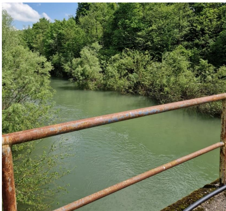
Slika 4.9 Most Pont sur la Dobra
