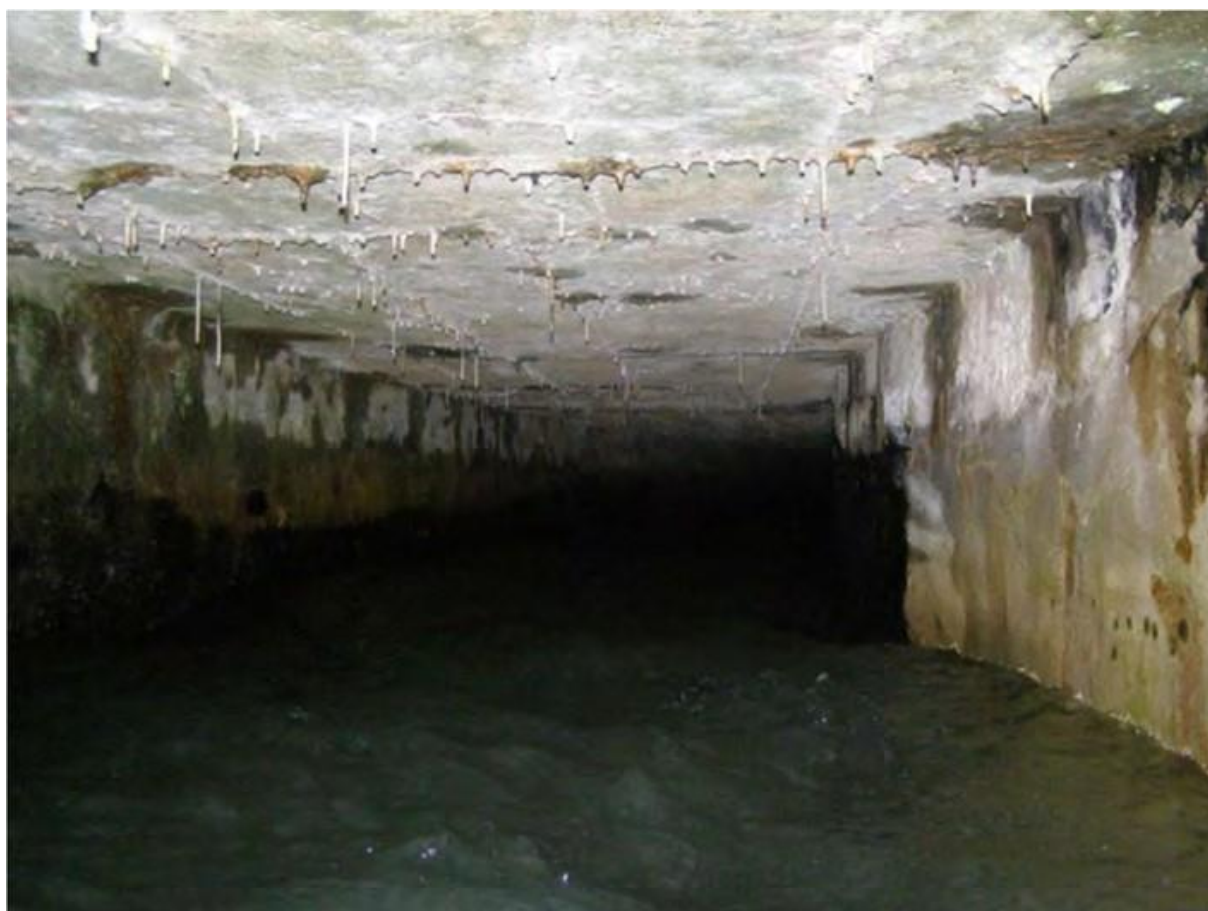
Slika 4.4. Unutrašnjost dovodnog tunela [3]
