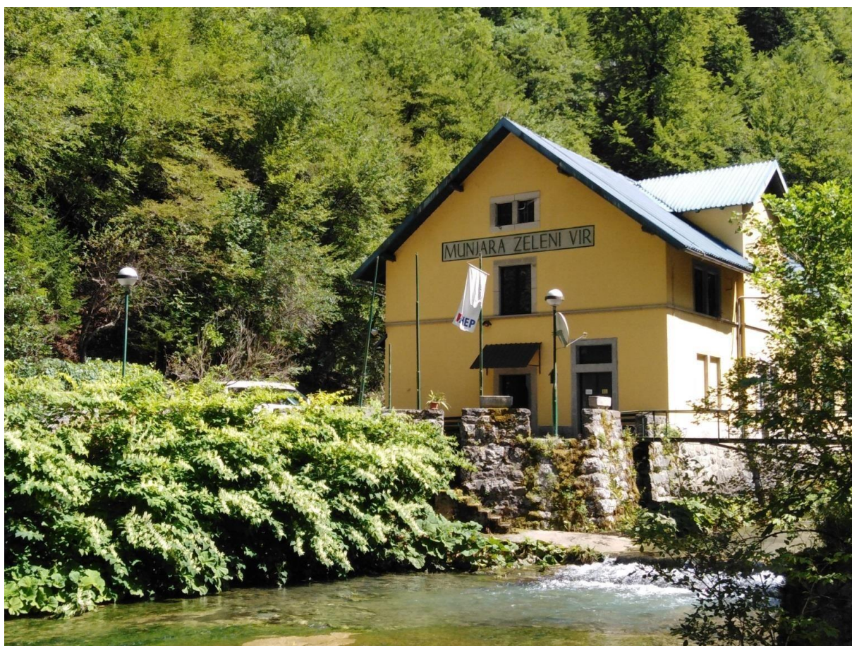
Slika 4.2. Hidroelektrana Zeleni Vir
