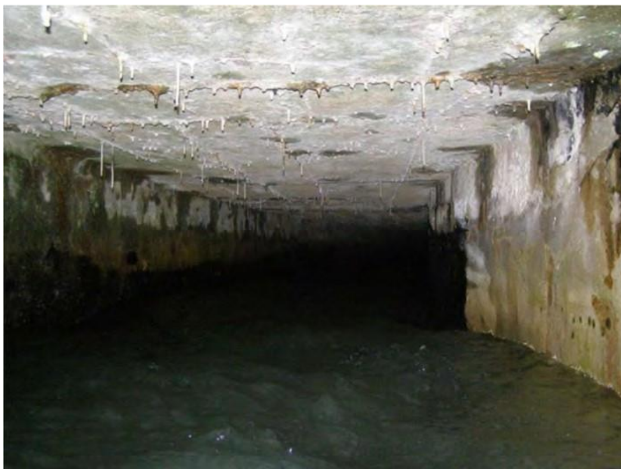
Slika 4.4. Unutrašnjost dovodnog tunela [3]
