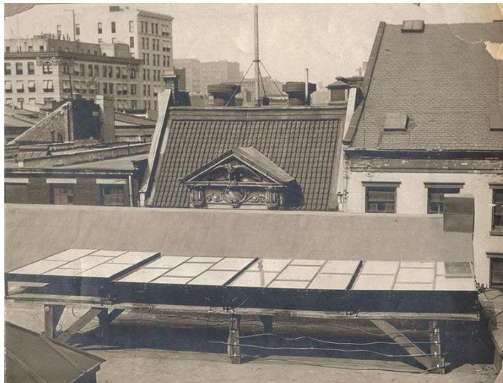
Slika 2.9. Slika prvog solarnog panela instaliranog na krovu [7]
