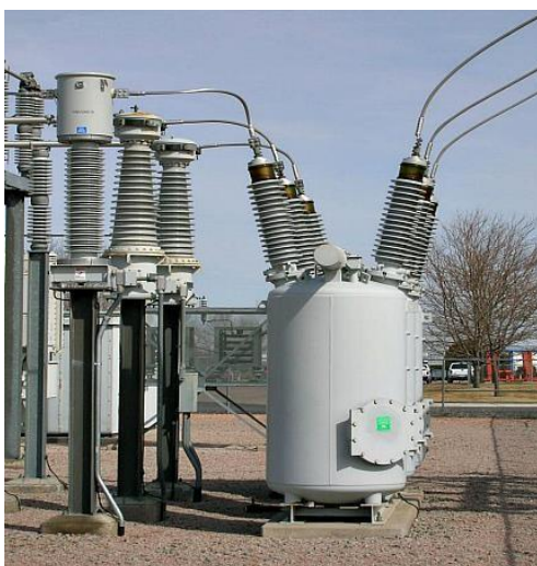
Slika 4.1. Uljni prekidač
