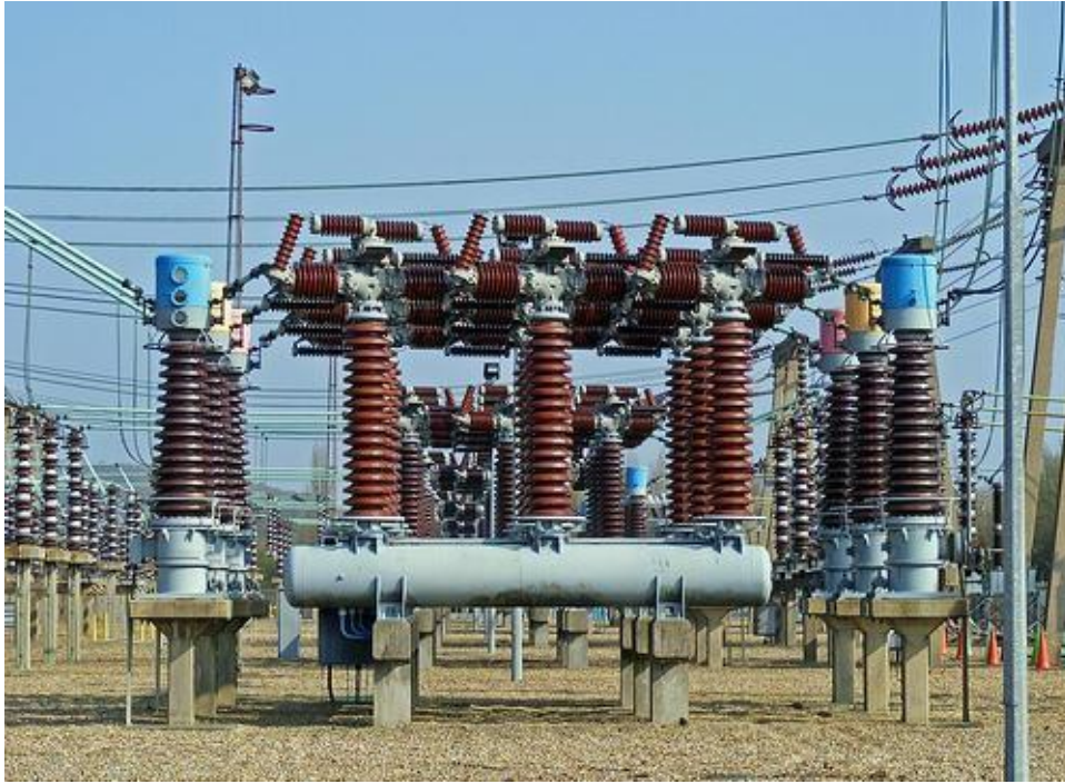
Slika 4.5. Zračni prekidač
