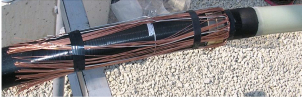
Slika 6.1: Priprema visokonaponskog kabela za spajanje [2]
