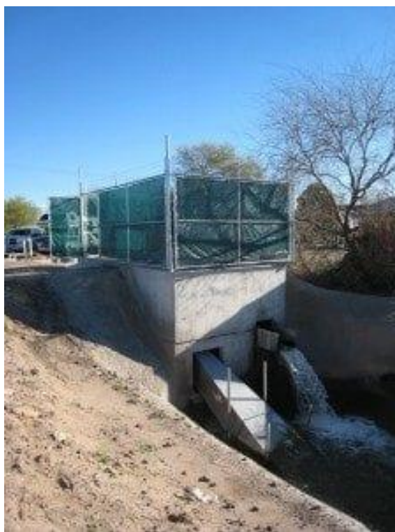
Slika 3.8. Odvodni kanal HE Buckeye, USA [34]
