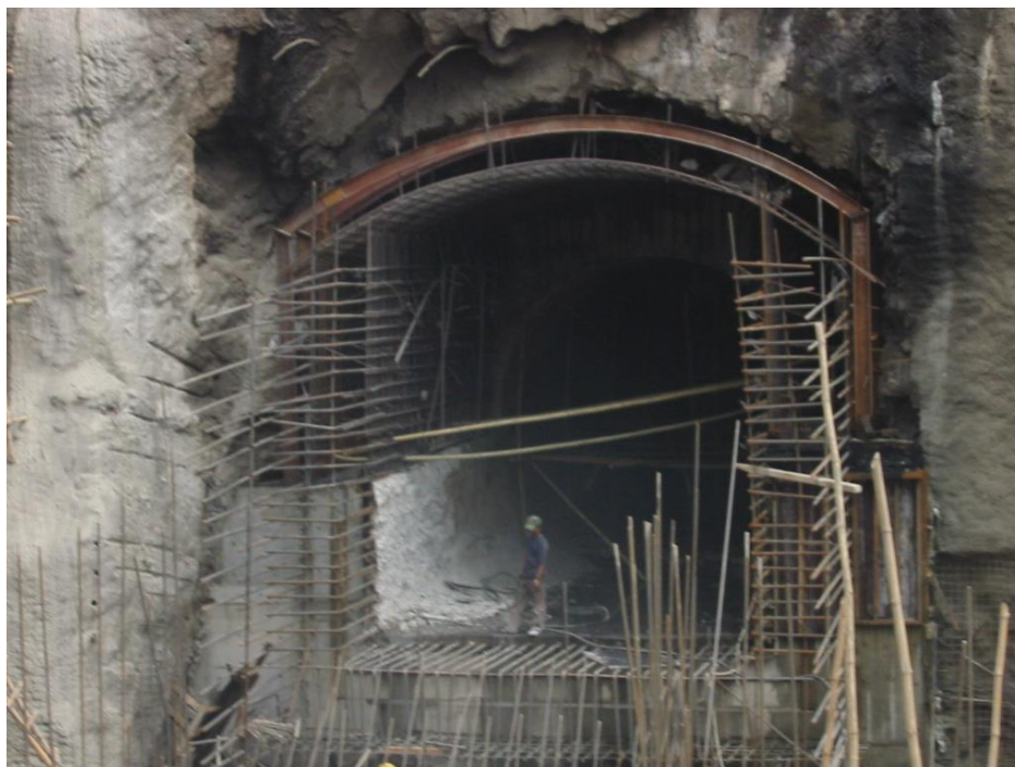
Slika 3.2. Ulaz u dovodni kanal [22]
