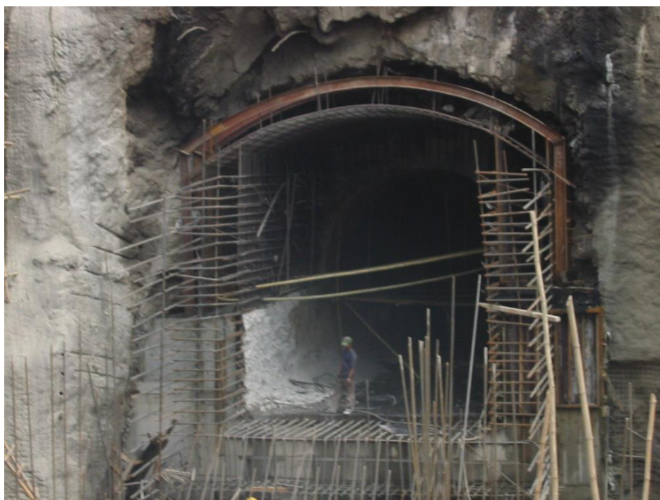
Slika 3.2. Ulaz u dovodni kanal [22]
