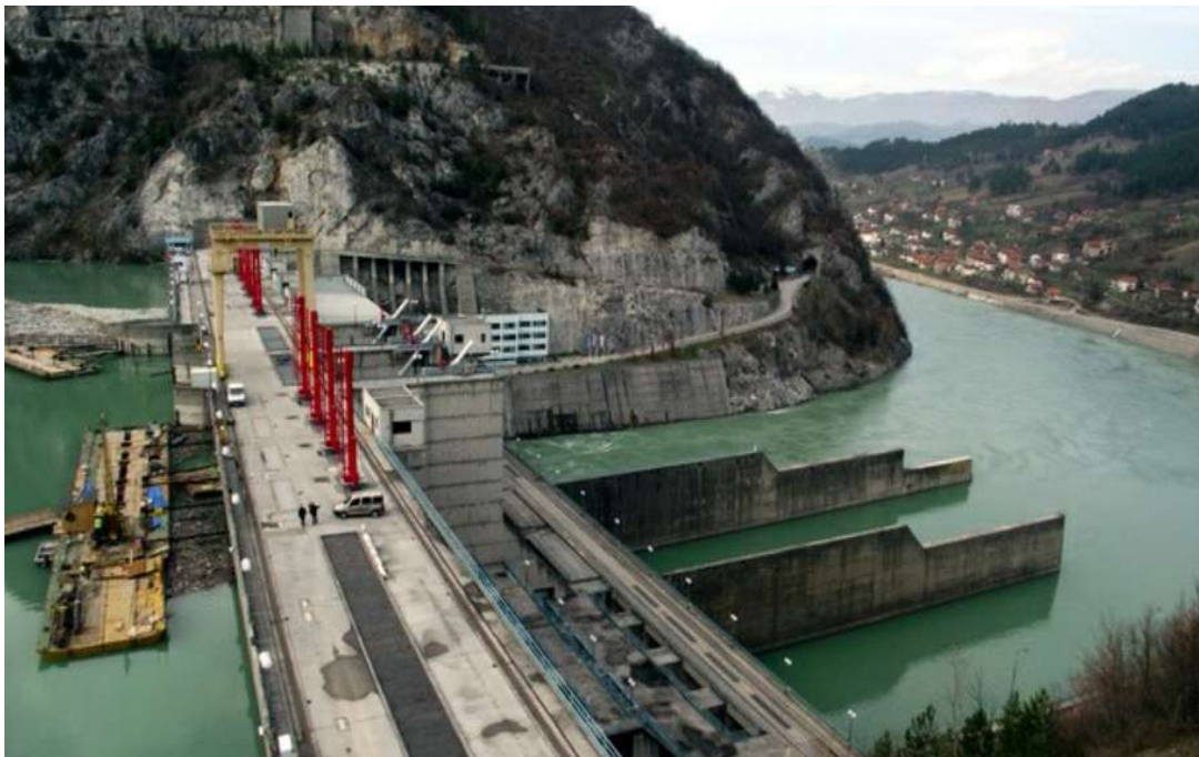
Slika 5.1. Hidroelektrana Zakučac (preuzeto sa: http://www.energypress.net/rekonstruirana-he-zakucac/ )
