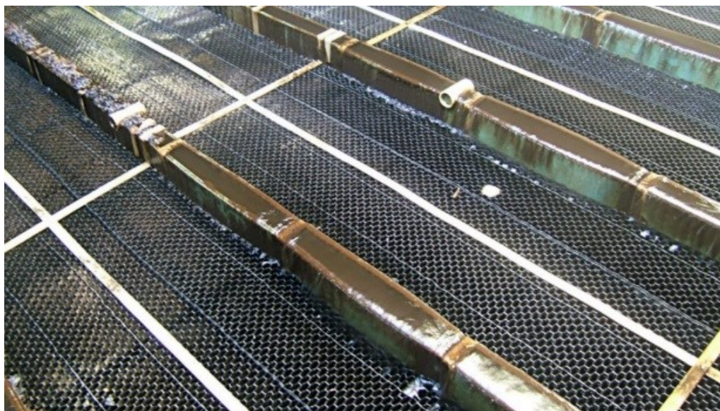
Slika 3.2. Razvodni kanali i ćelije rashladnog tornja [4]
