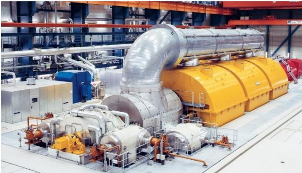
Slika 2.16. Turbogenerator [3]
