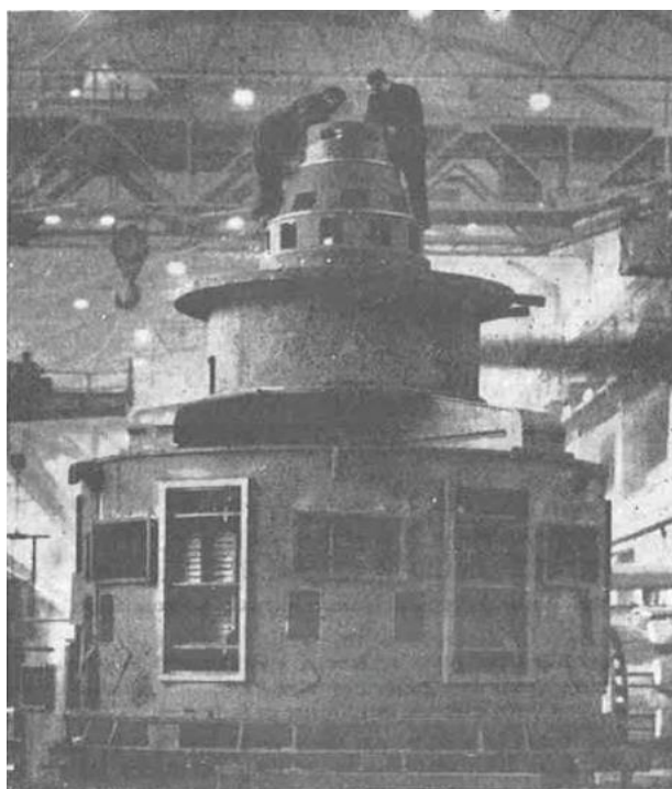
Slika 2.15. Hidrogenerator postavljen vertikalno s osovinom [4]
