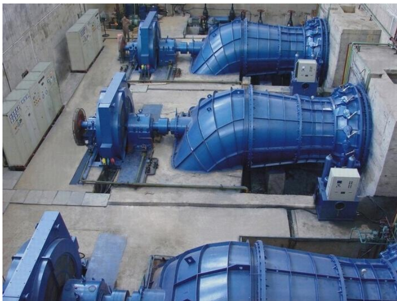
Slika 4.4. Cijevna turbina [8]
