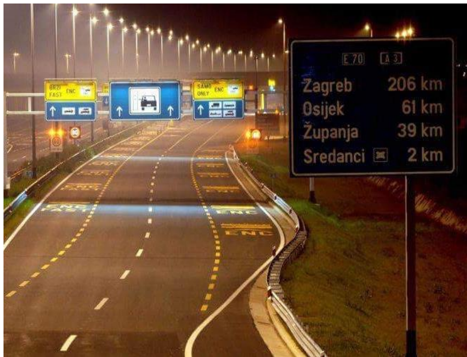
Slika 10. Neadekvatna rasvjeta na autocesti [26]
