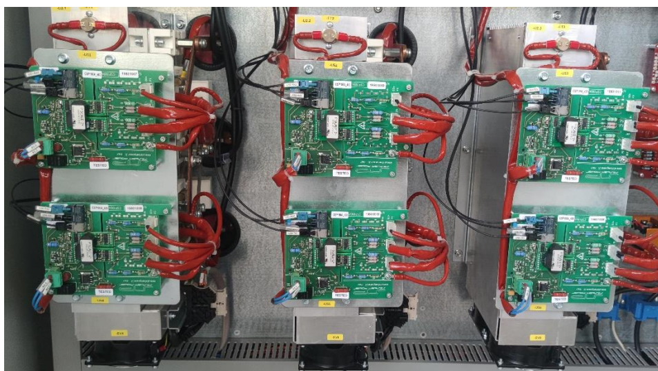
Slika 2.4. Energetski dio izmjenjivača
