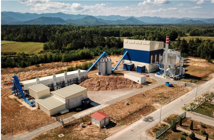
Slika 2.7. Kogeneracijska elektrana na biomasu u Gospiću
