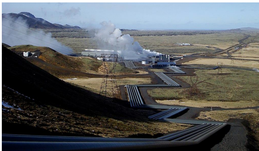
Slika 2.8. Geotermalna elektrana Hellisheiði (Island) [11]
