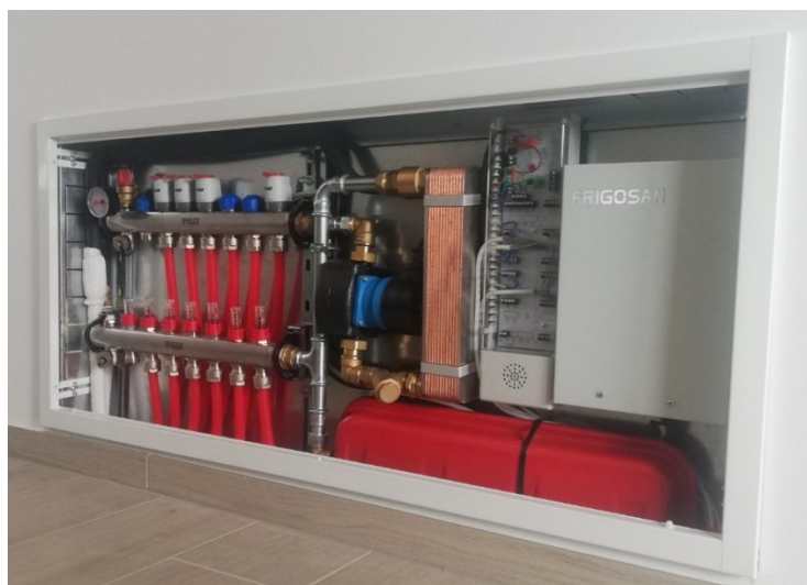
Slika 5.3. Originalni sustav za integraciju dizalice topline
