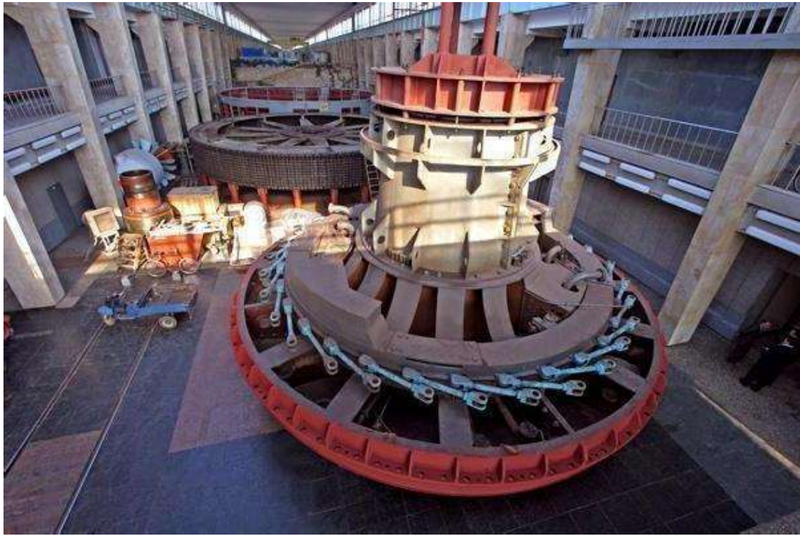
Slika 2.8. Rotor hidroelektrane Saratov u Rusiji [9]
