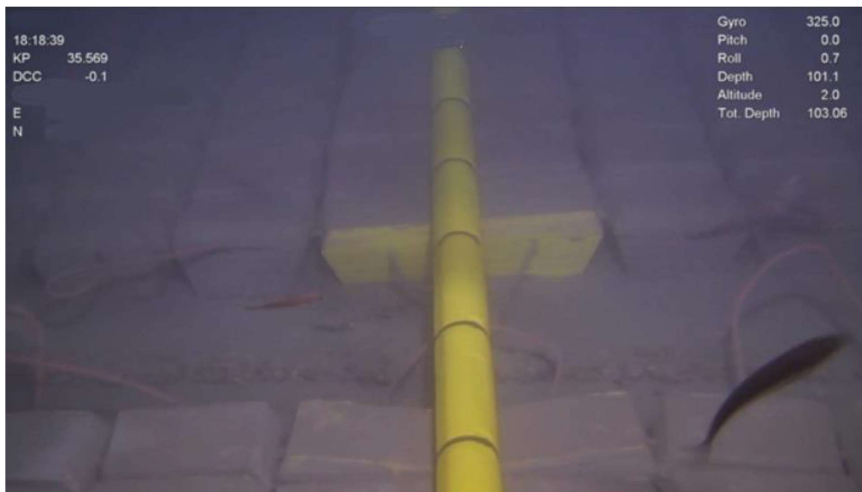
Slika 7.8: Prikaz kabela s betonskim (blok) madracem [1]
