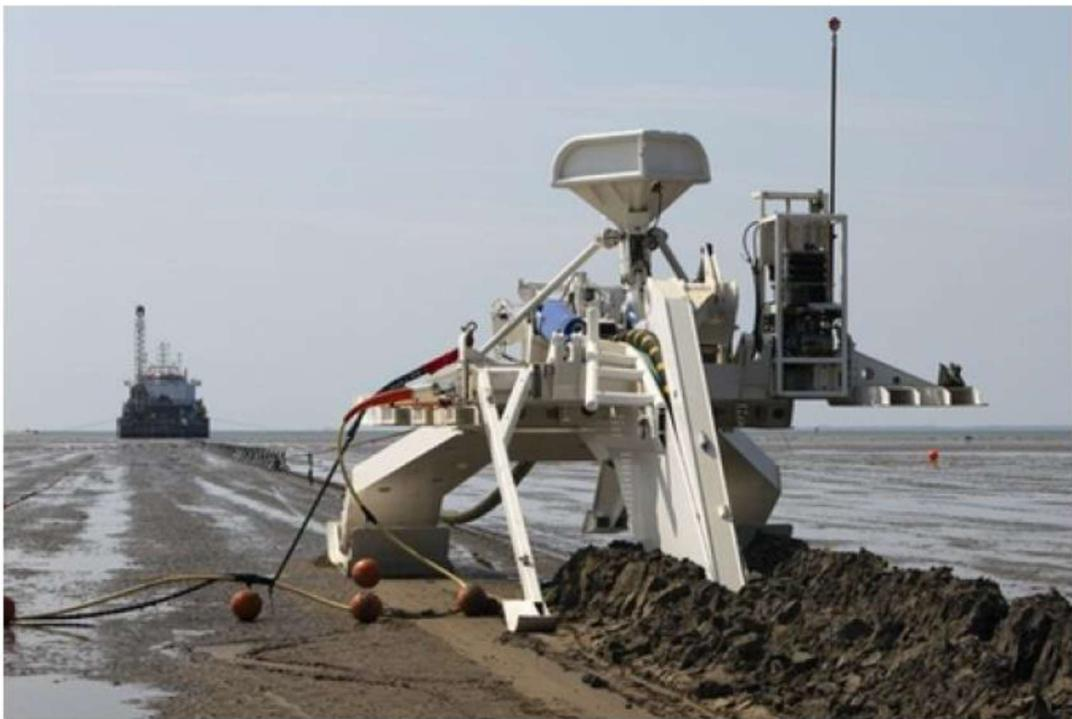
Slika 7.5: Oprema za plug na kopnu [1]
