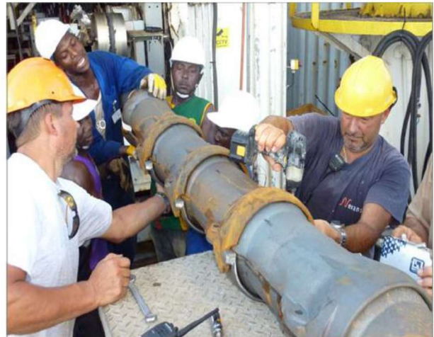
Slika 7.7: Kabel s ljuskom od lijevanog željeza i instalacija ljuske od lijevanog željeza na kabel (uz nepoštivanje današnjih sigurnosnih mjera) [1]
