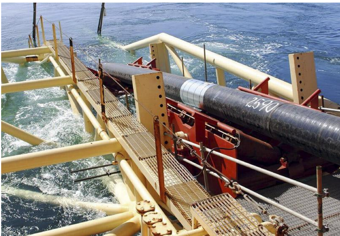
Slika 4.3. Ispuštanje kabela u more [7]
