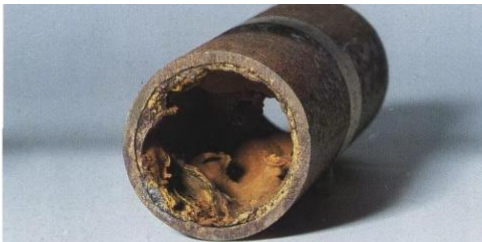
Slika 3.14 Bakterijska korozija ugljičnog čelika [8]
