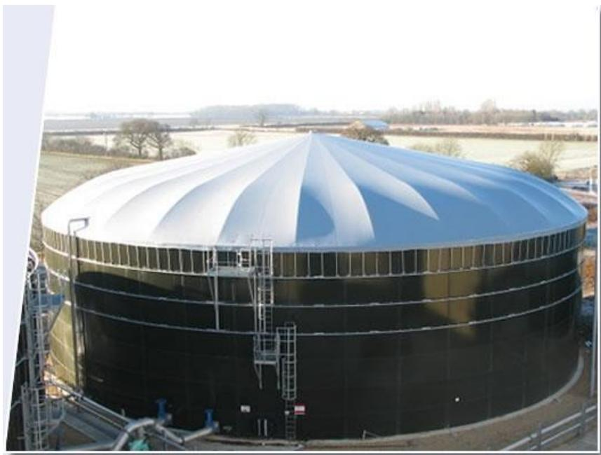
Slika 6.6 Membranski spremnik digestata
