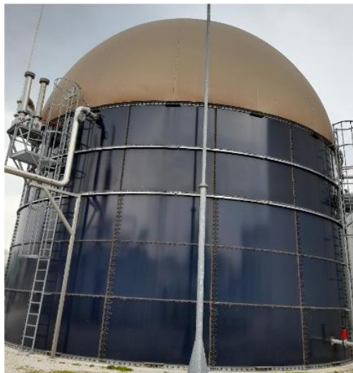
Slika 4.3 Digestor s nepropusnom mebranom za skladištenje bioplina [19]
