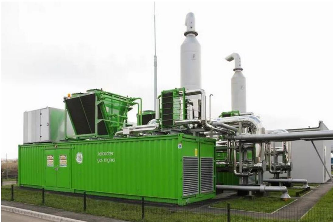
Slika 5.1 Kontejnerska izvedba "Jenbacher" plinskog motora [20]
