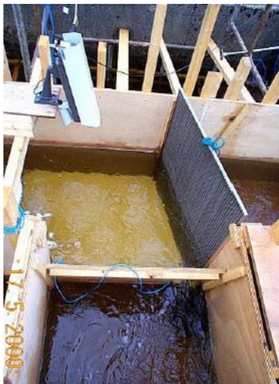
Slika 3.4. Zaštitna rešetka za obilaženje hidroelektrane [8]
