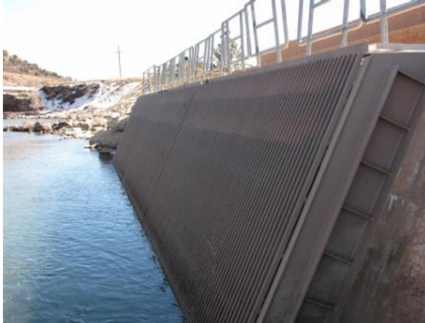
Slika 3.2. Zaštitna rešetka s bočnim nosačem [5]
