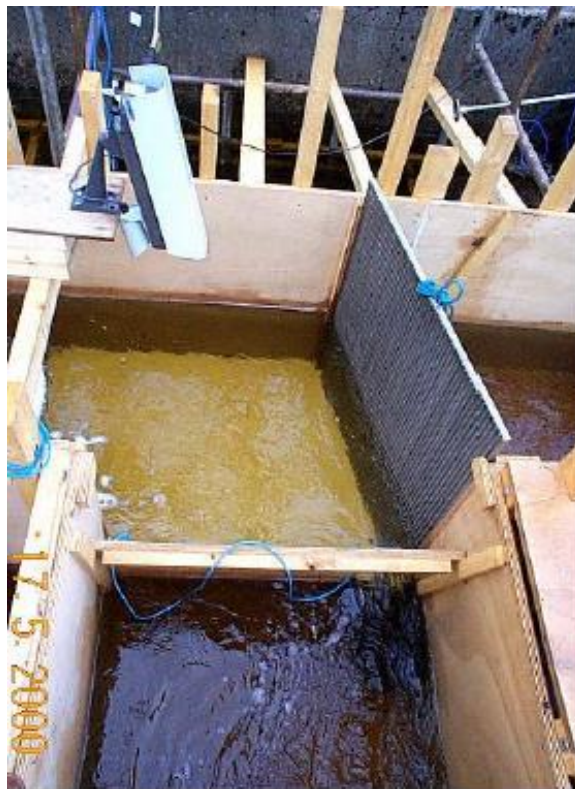
Slika 3.4. Zaštitna rešetka za obilaženje hidroelektrane [8]
