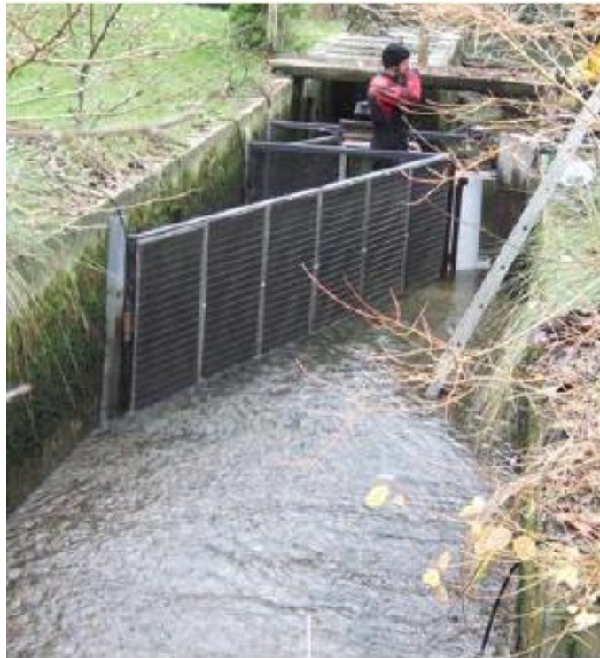
Slika 4.1. Izrada eksperimentalne rešetke [9]
