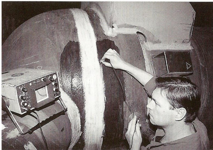
Slika 4.12. Ultrazvučna kontrola zavarenog spoj
