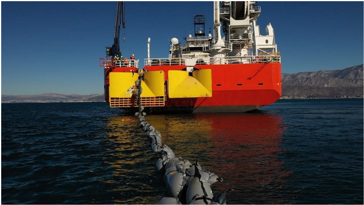
Slika 4.11. Polaganje na obalnom području pomoću plutajućih balona [21]
