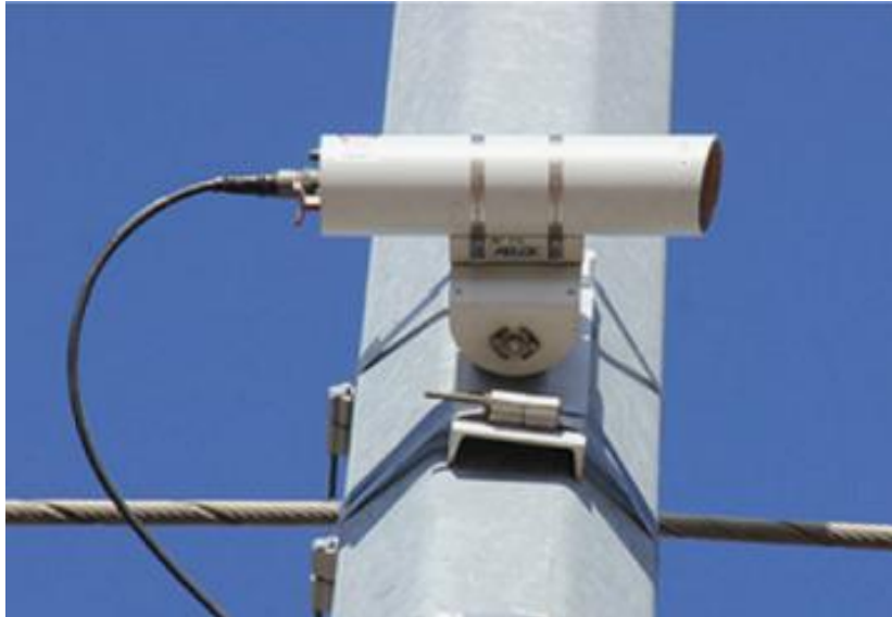
Slika 5.15. Video kamera iz sustava Span Sentry (EDM)
