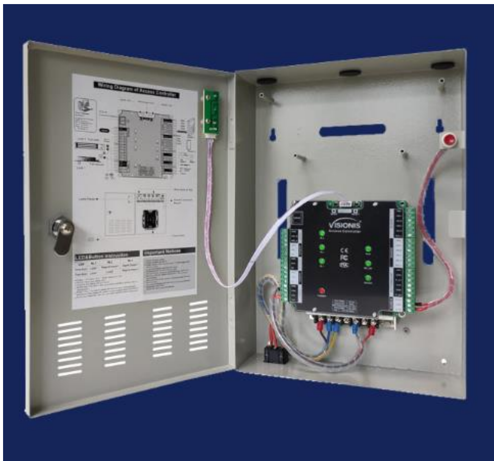
Slika 2.9. Kontroler u elektroormaru [16]
