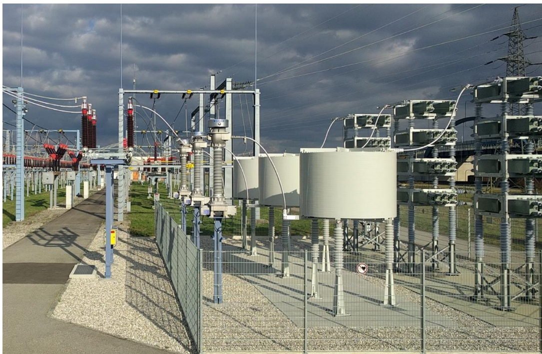
Slika 16. Primjer MSCDn (kondenzatorska baterija i prigušnice) nazivne snage 70 Mvar ugrađene na 115 kV
