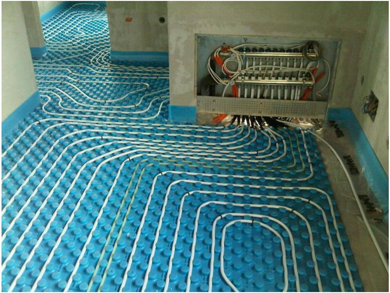
*Slika 3.5. Instalacija podnog grijanja s razvodnim ormarićem [10]*
