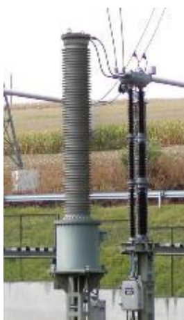
Slika 3.26. Naponski transformator izoliran plinom SF 6 [20]
