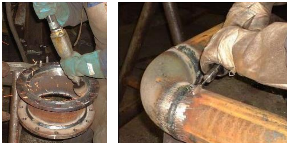
Slika 3.14. Brušenje zavarenog prirubničkog spoja (lijevo) i koljena (desno)
