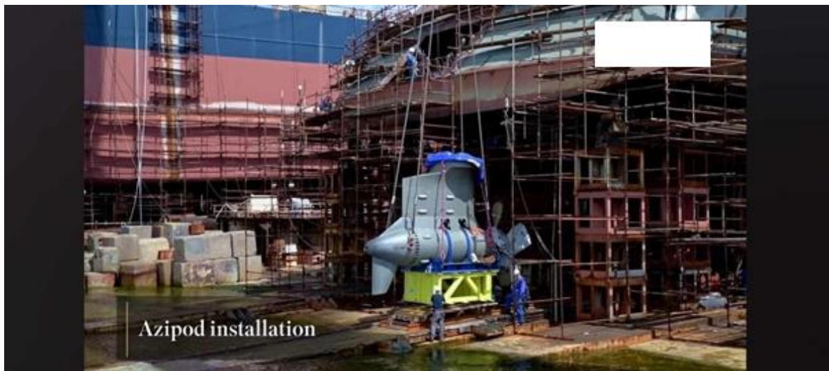
Slika 30. Montaža prouplzijskog sustava na navozu
