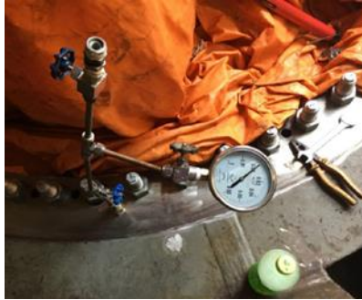
Slika 51. Tlačenje upravljačkog modula
