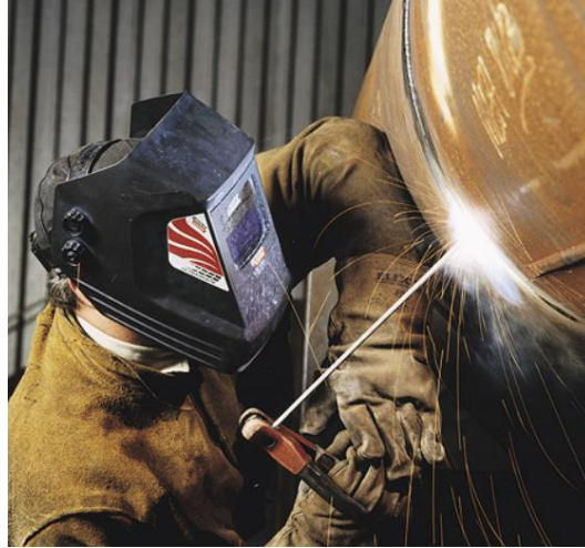
Slika 14. Zavarivanje REL postupkom
