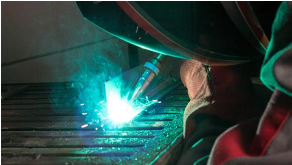
Slika 13. Zavarivanje MIG/MAG postupkom
