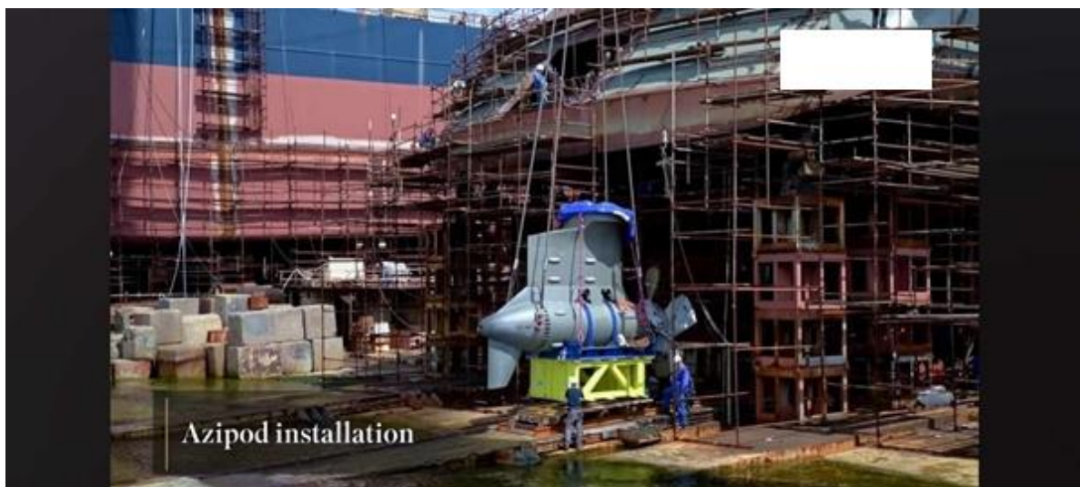
Slika 30. Montaža prouplzijskog sustava na navozu
