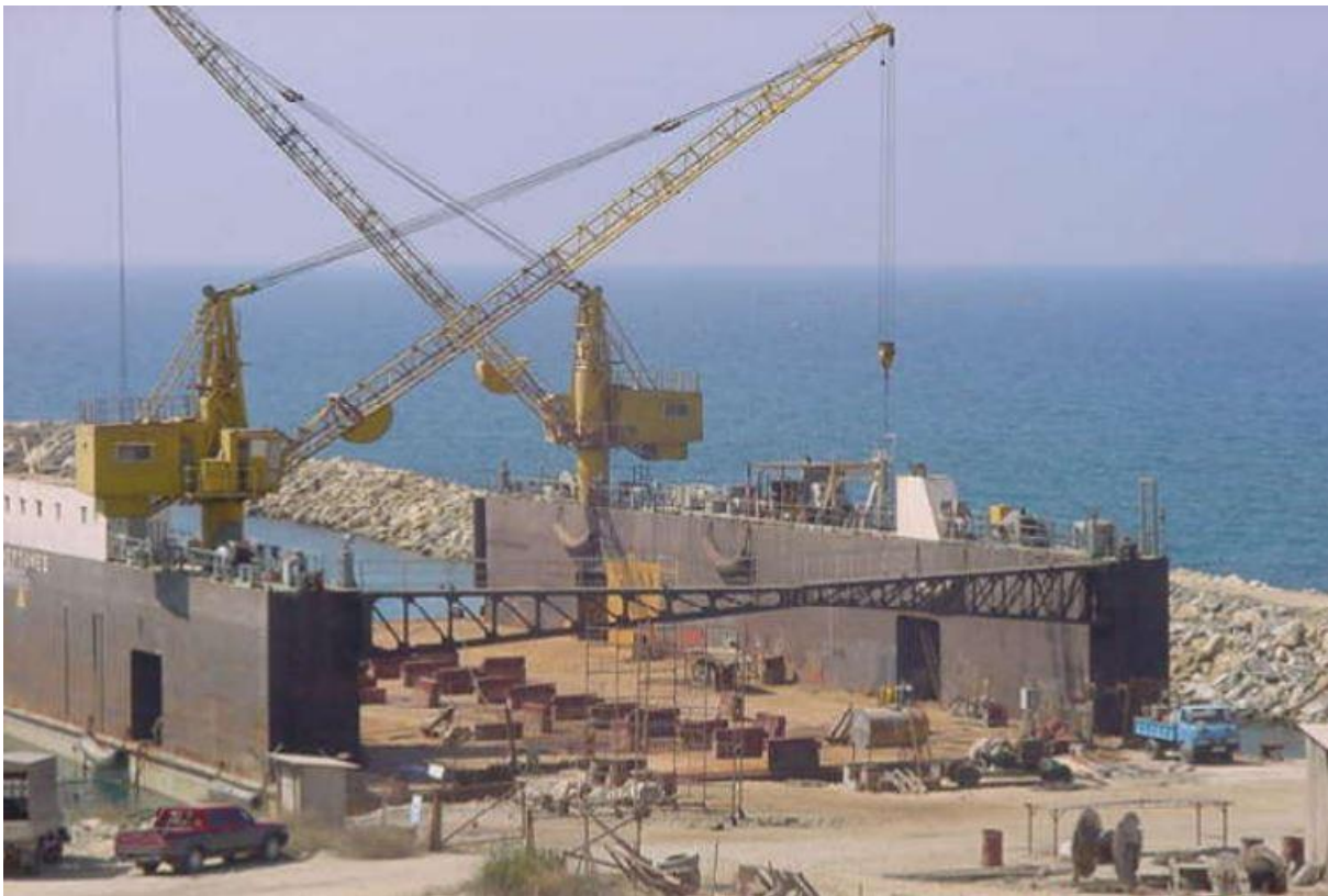
Slika 2.6. Monolitni plutajući dok [1]
