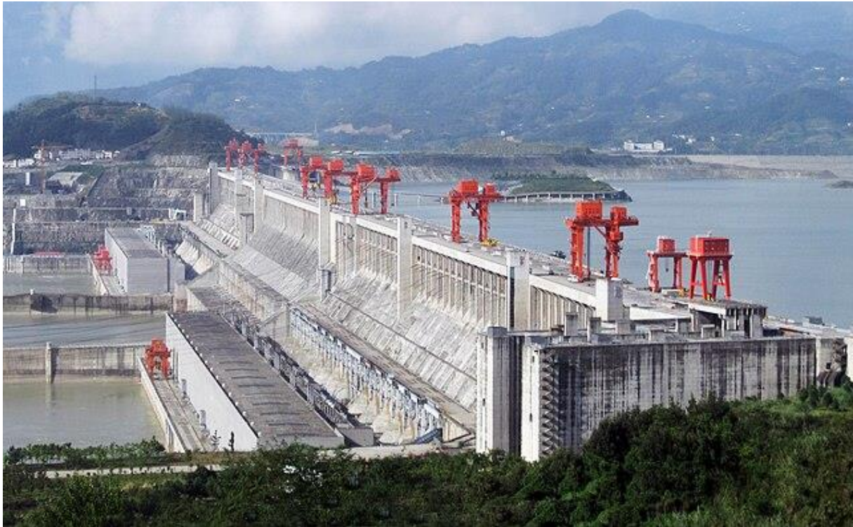
Slika 2.2. Hidroelektrana Tri klanca [3]
