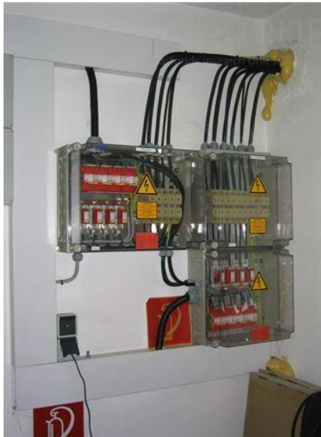
Slika 6.4. Razvodni ormarići [17]
