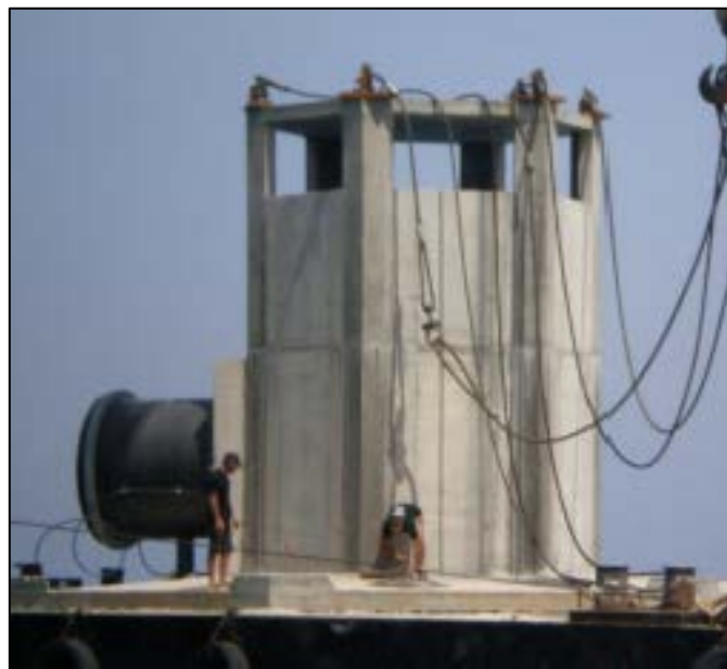
Slika 3.1 Usisno postrojenje (Alžir) [8]
