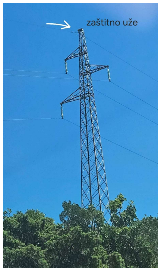
Slika 2.8. VN metalni dalekovod sa zaštitnim užetom
