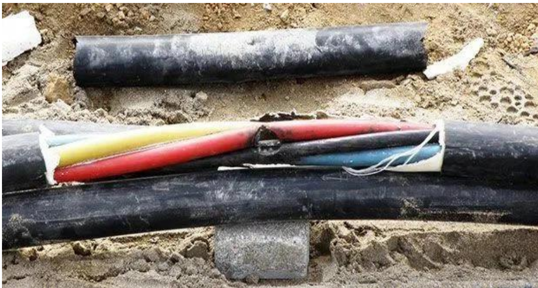
Slika 2.10 Zagrijavanje kabela
