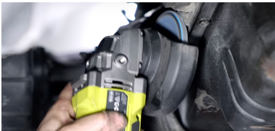
Slika 6.9. Priprema površine nalijeganja turbopuhala na motor
