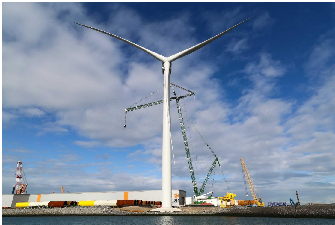
Slika 3.4. Priobalna vjetroturbina Haliade-X u Rotterdamu [12]
