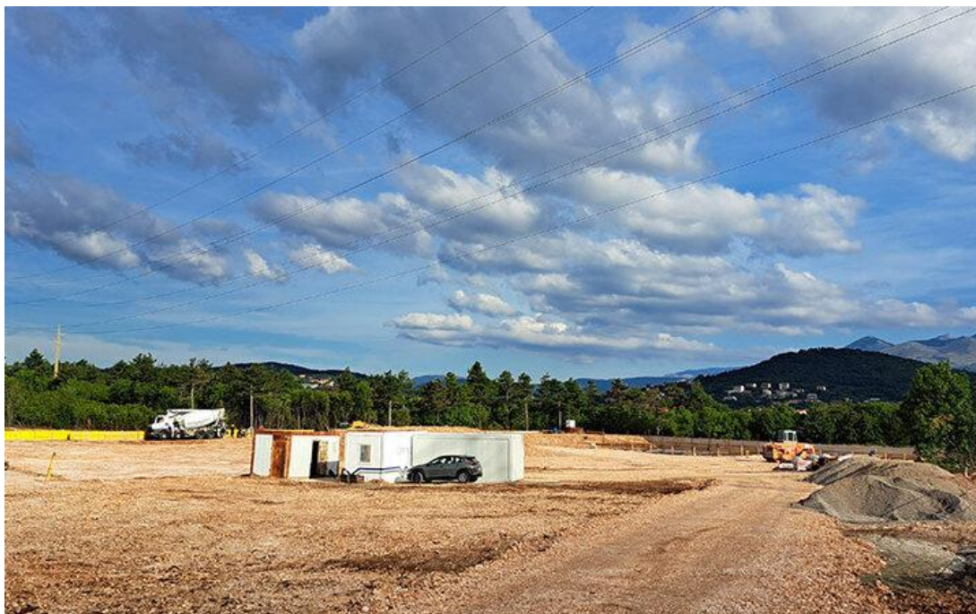
Slika 4.1. Početak izgradnje TS 110/20 kV Mavrinci [17]
