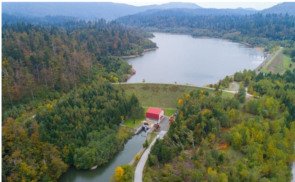
Slika 3.3 Reverzibilna hidroelektrana Lepenica, Fužine [7]
