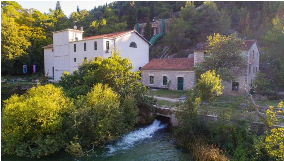
Slika 3.5 Hidroelektrana Jaruga, rijeka Krka [11]
