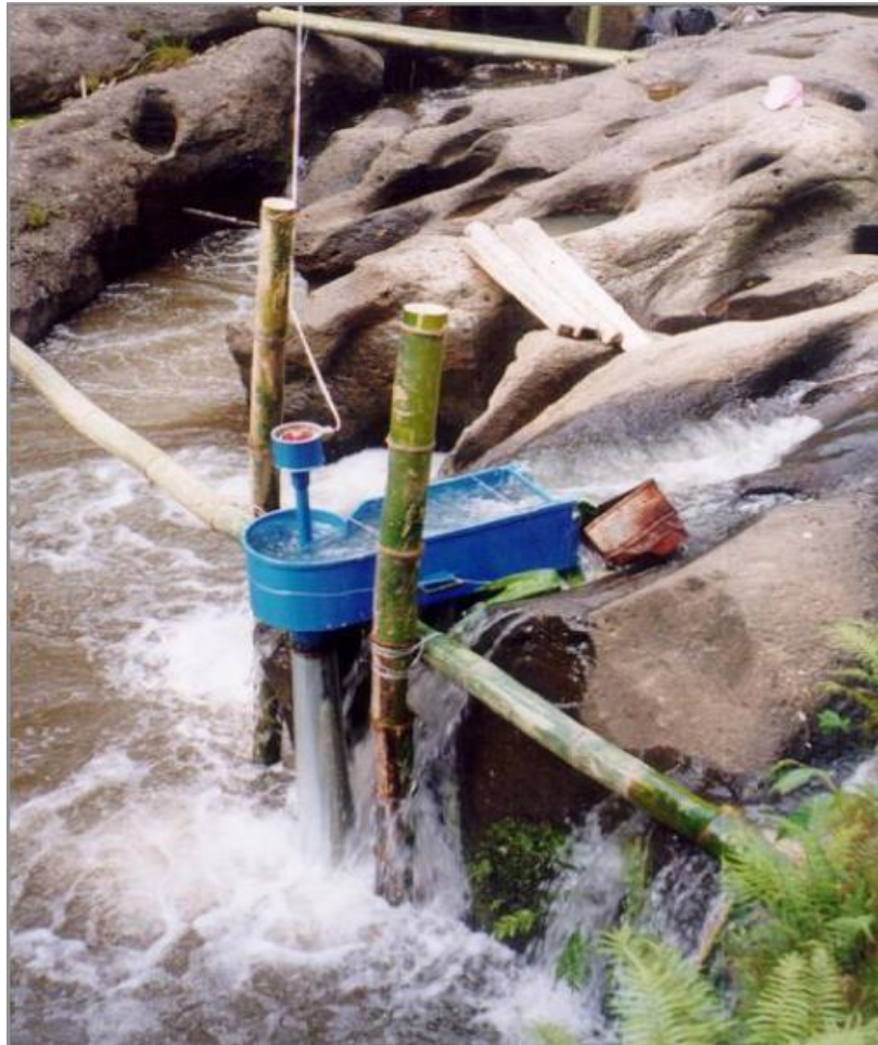
Slika 3.7 Primjer piko hidroelektrane sa snagom od 200 W [16]
