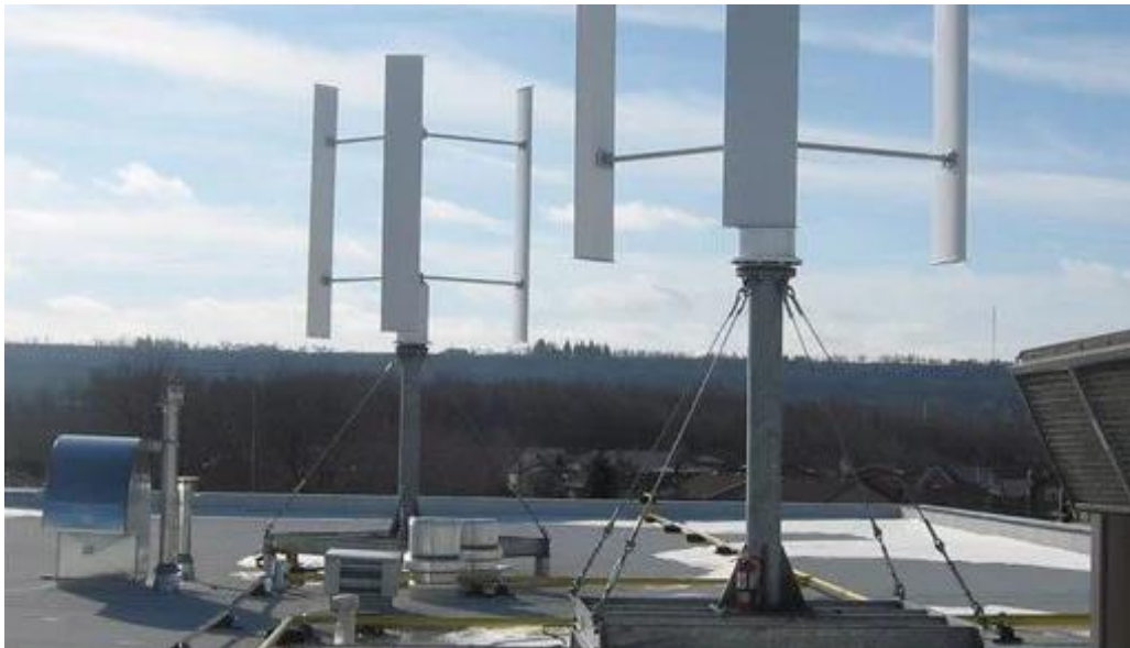
Slika 2.9. Giromill / H-rotor [13]
