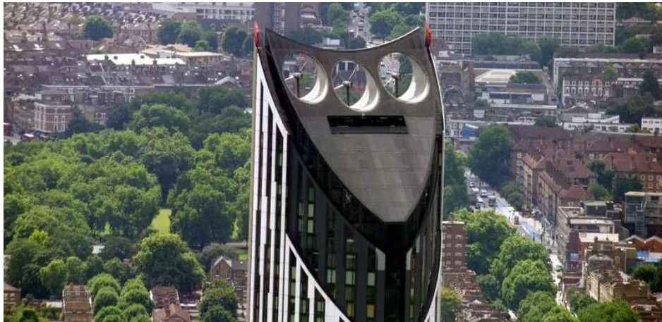
Slika 2.5. Strata stambeni toranj s tri integrirane vjetroturbine [18]
