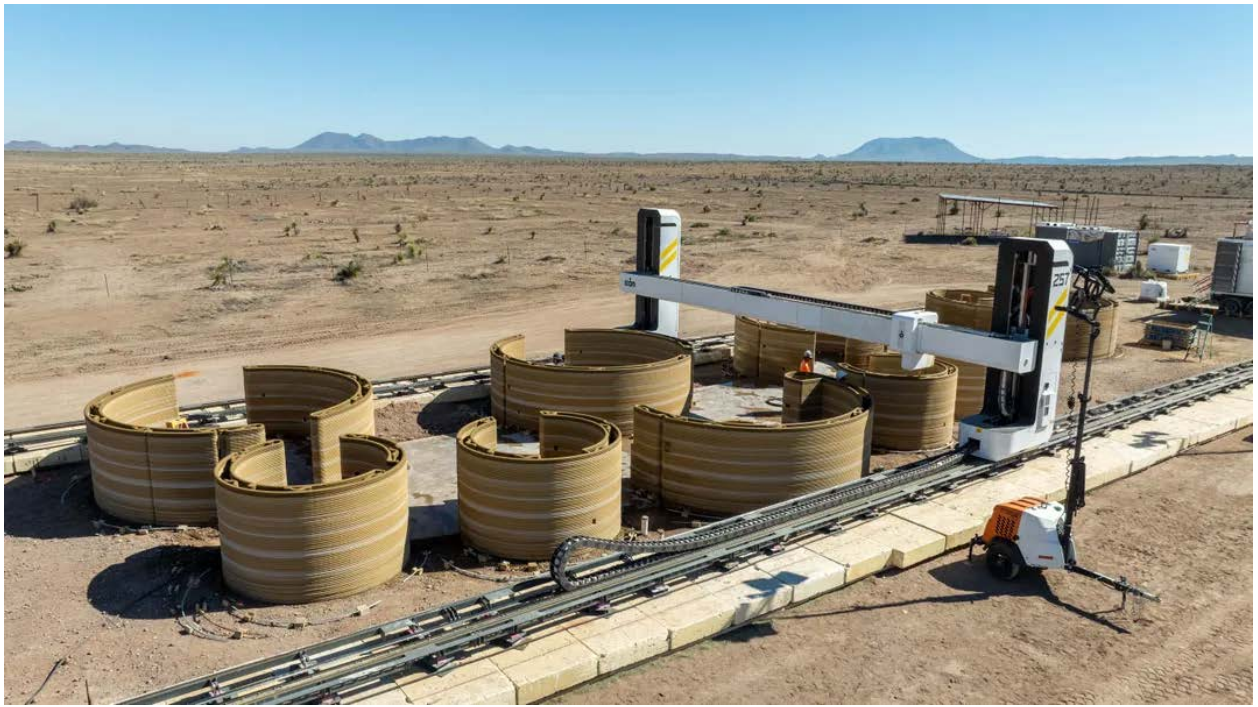
Slika 2.9. Izgradnja hotela El Cosmico u Teksasu [10]
