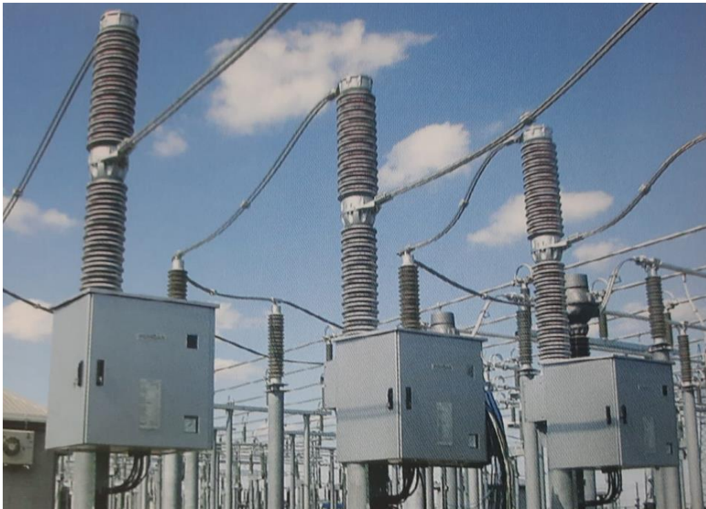
Slika 2.4. SF6 prekidači[1]
